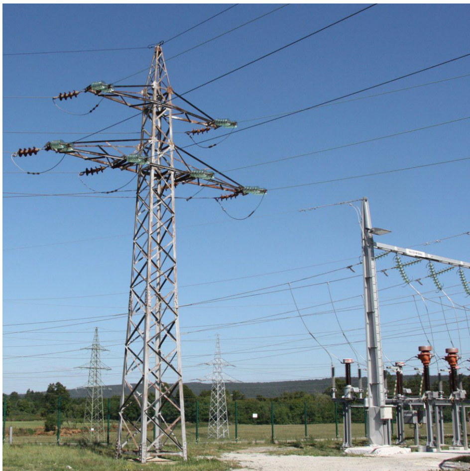
Slika 2: Obstoječ 35 kV dvosistemski steber na SM1.
